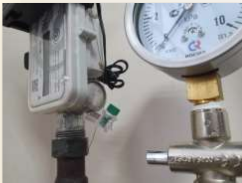
Строительно-монтажные работы по газоснабжению Пчевского ветучастка
